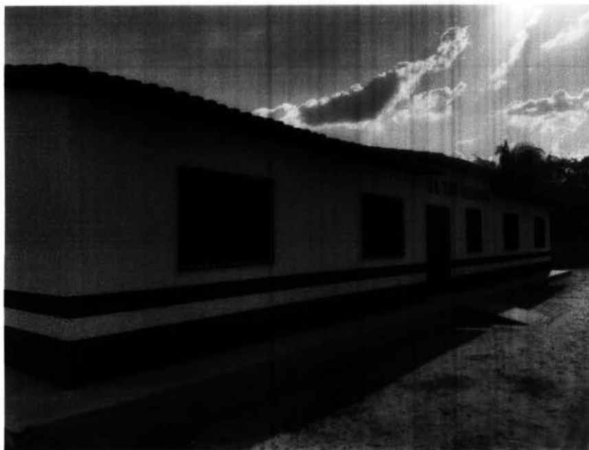
imagem 10 : vista da fachada principal da escola com rampa de acessibilidade
