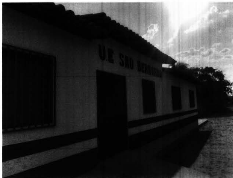
Imagem 01: execução de pintura externa em paredes, esquadrias de ferro e madeira
