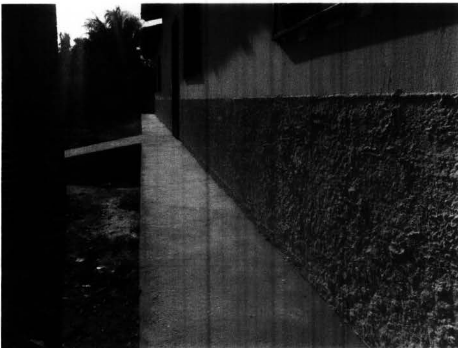
imagem 08 : execução de calçada externa e rampa de acesso ao banheiro
