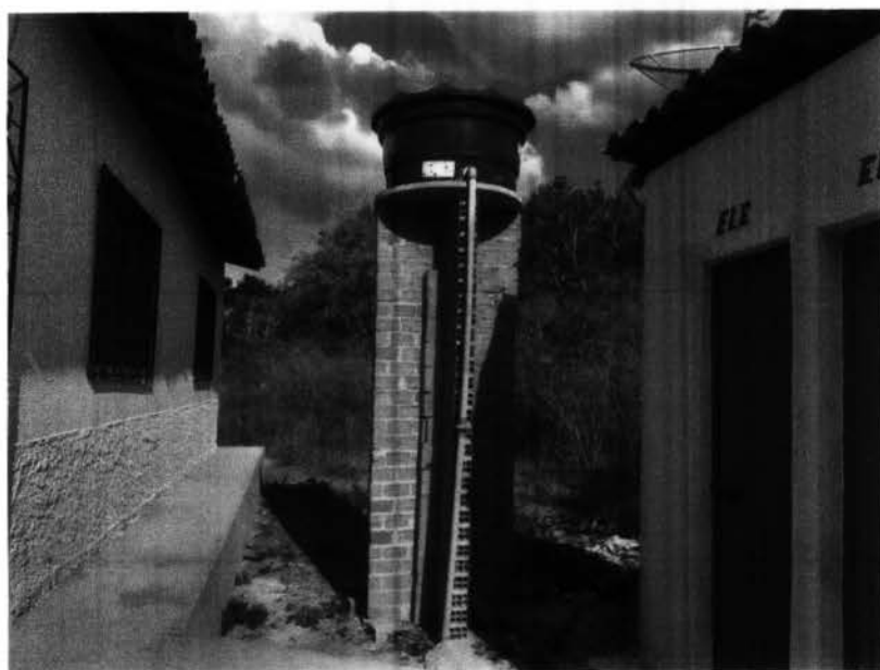
imagem 02 : execução de estrutura de sustentação da caixa d'água de 500l e instalações hidráulicas.
