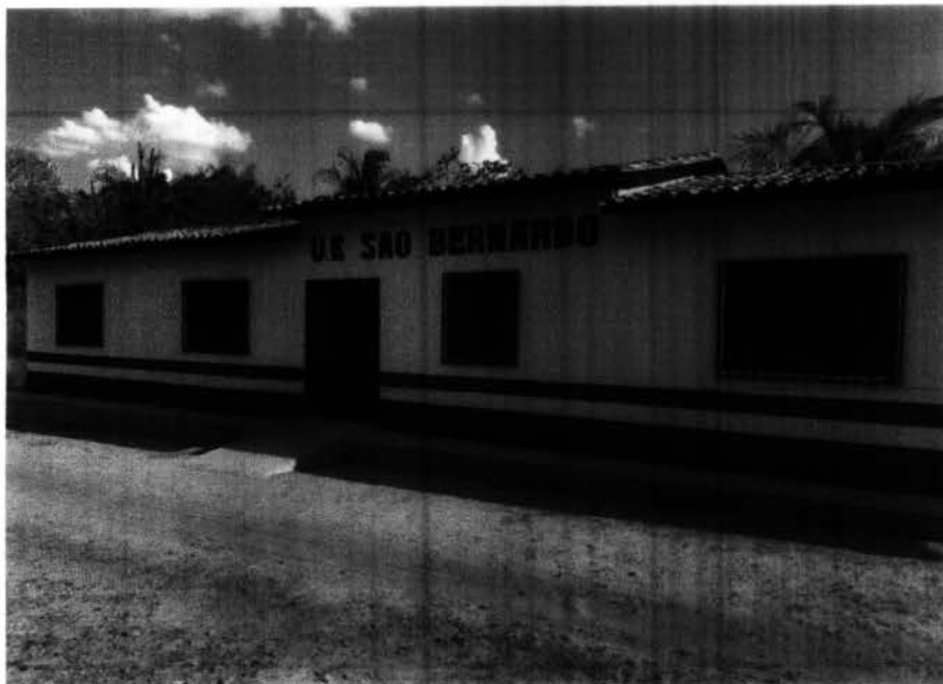
imagem 09 : execução de retelhamento da cobertura
