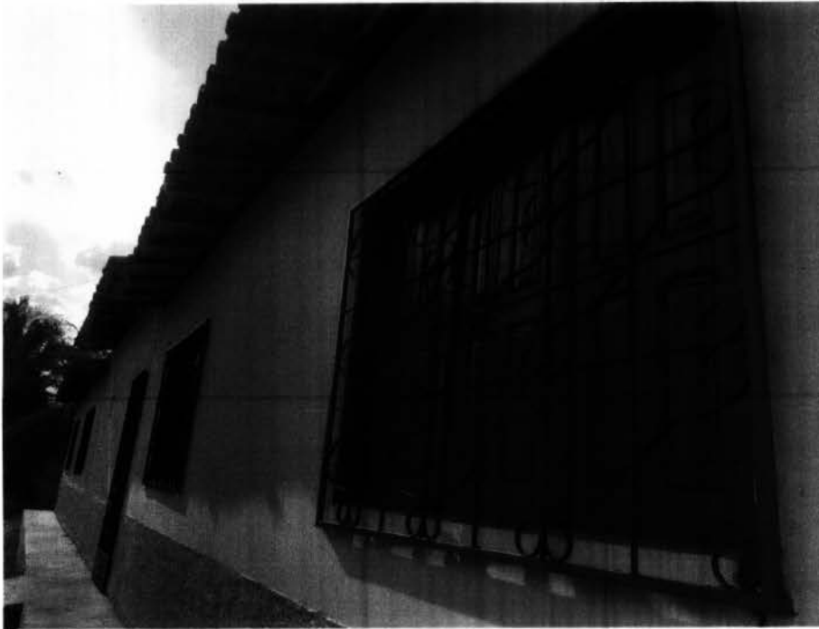
imagem 05 : execução de grades de proteção metálicas e pintura
