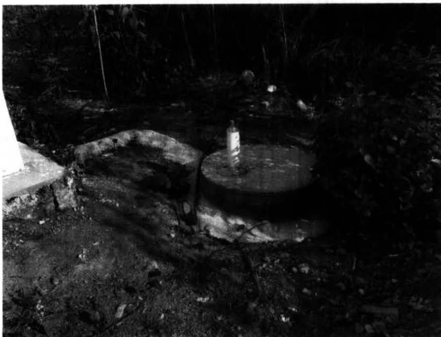
imagem 04 : execução de fossa séptica
